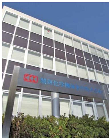
本社管理棟：太陽光発電を壁に施し、CO2削減に貢献
