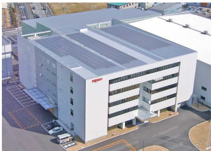
平成20年に新社屋として尼崎市臨海地区に建設
