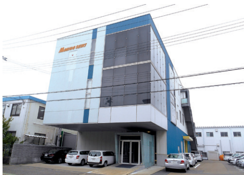
国内外へと洗浄機を送り出している明石本社です
