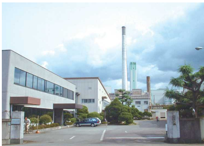
原皮から一貫生産している本社工場
